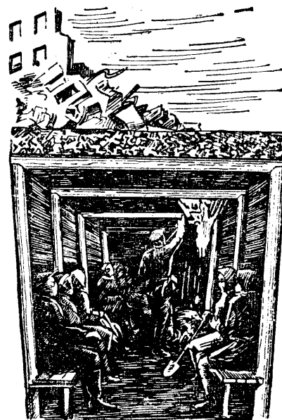
Рис. 24. Устройство проема в перекрытии для выхода людей из заваленного укрытия.
